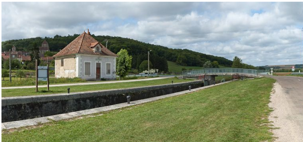
Vue d'ensemble du site d'écluse.
