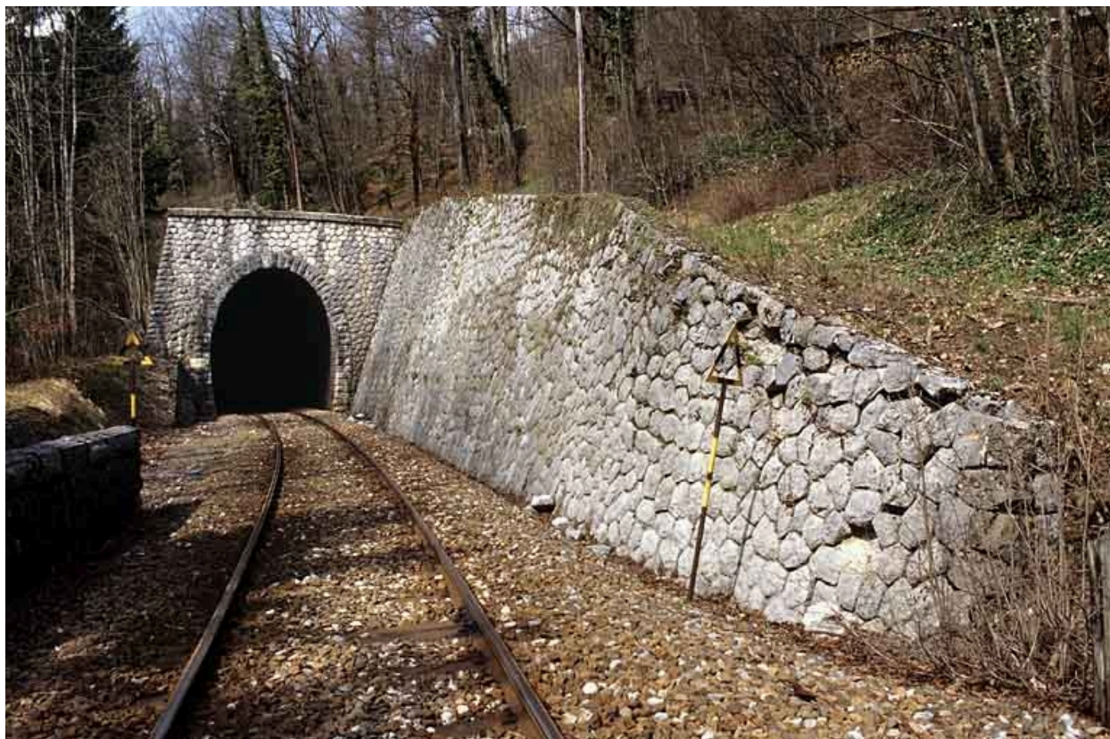
Vue d'ensemble de la tête côté Andelot-en-Montagne.
