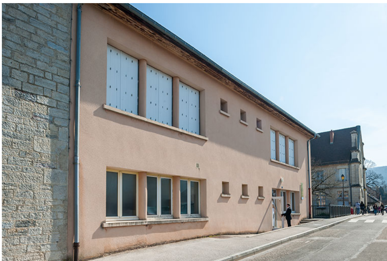
Annexe : façade antérieure, vue trois-quart.
