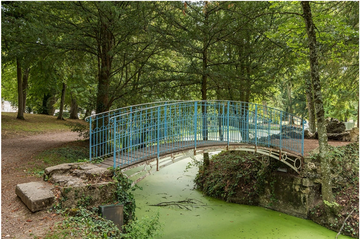
Passerelle métallique donnant accès à l'île.
