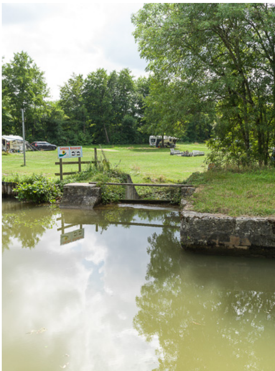
Vue du déversoir de superficie.
