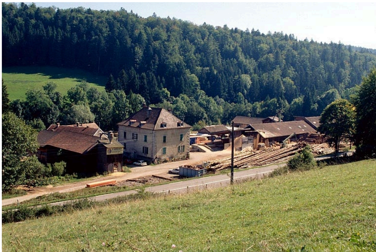
Chaux-des-Crotenay : forge, scierie, usine de parqueterie.
