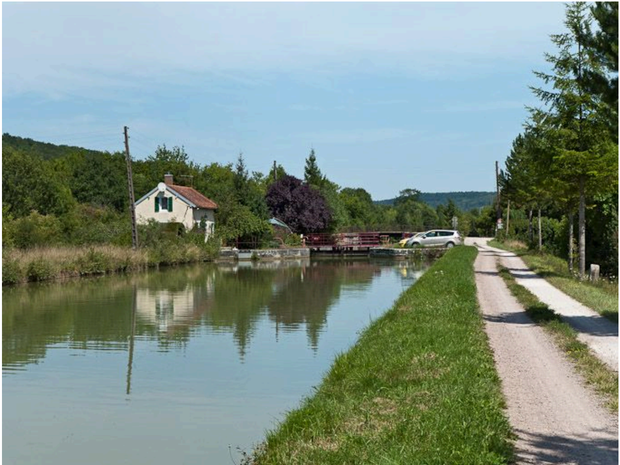
Vue du site d'écluse depuis l'amont
