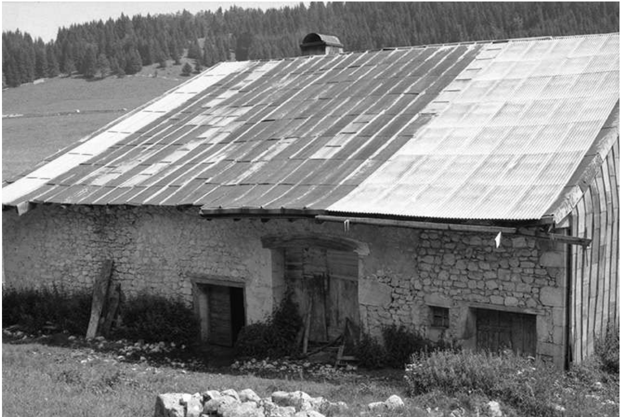
Façade postérieure, porte de grange, écuries.
