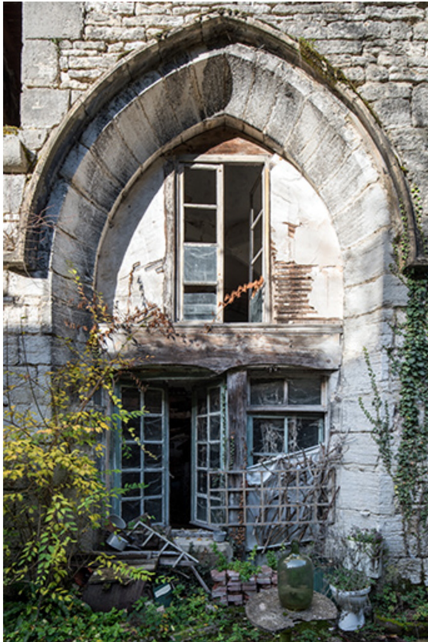
Fenêtre à arc brisé du chevet.
