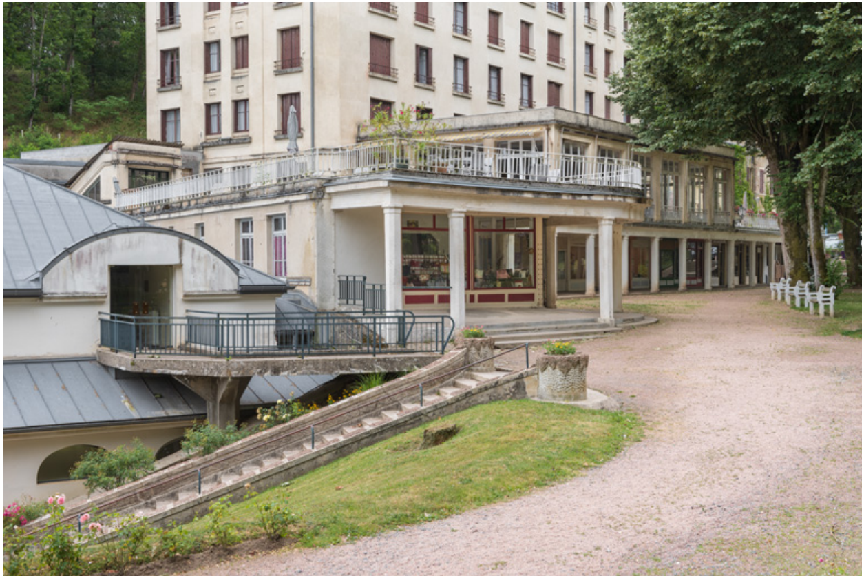
Portique de l'étage de soubassement et rampe descendant à l'établissement thermal.
