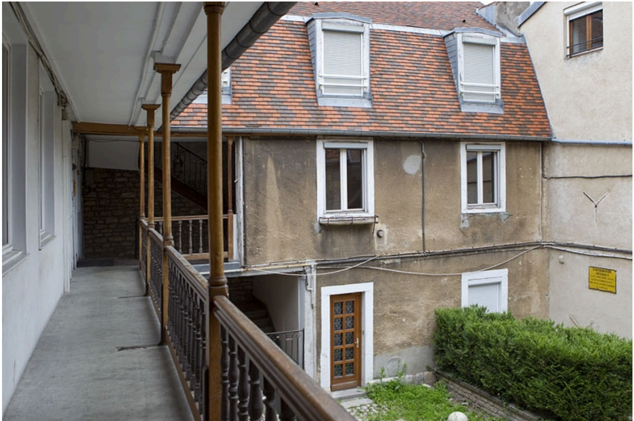
Détail de galerie sur cour du logis principal.
