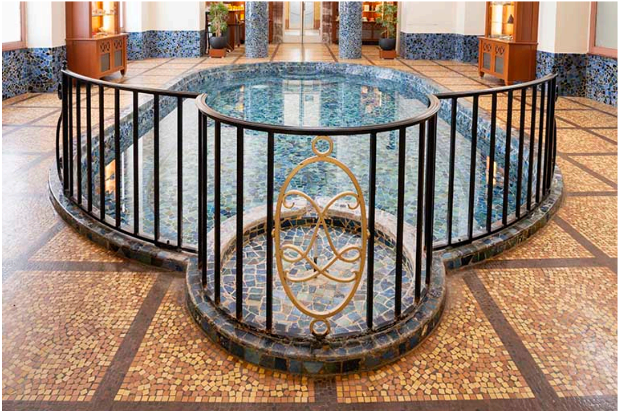
Piscine à l'emplacement du Bain des Capucins, détail du bassin, garde-corps au chiffre de Luxeuil.
