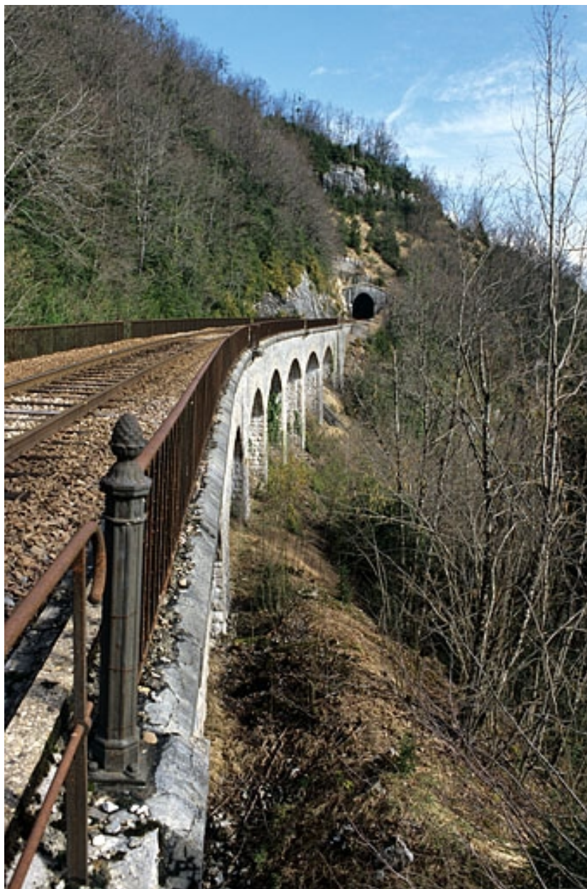
Viaduc de la Grande Roche et tunnel du Crapaud : vue d'ensemble, depuis le côté La Cluse (sud).
