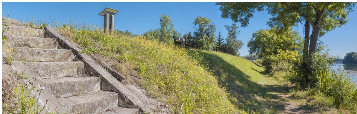
Escaliers du barrage. A droite, la Saône.
