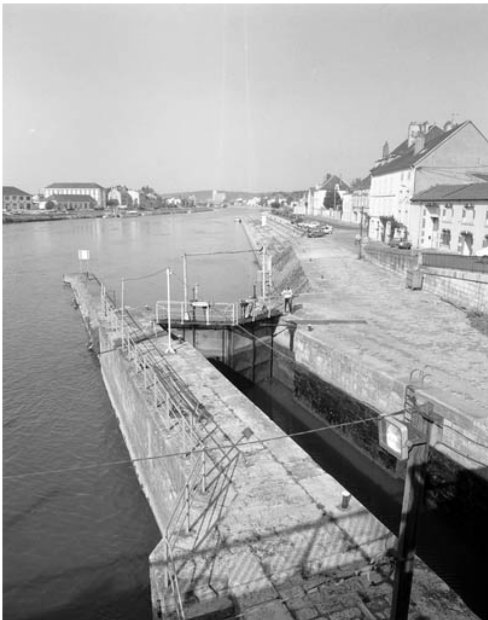
Vue d'ensemble rapprochée avec le quai Villeneuve.
