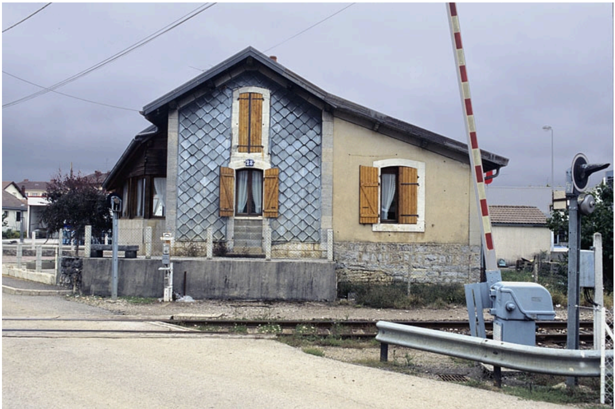
Façade sud (côté voie).
