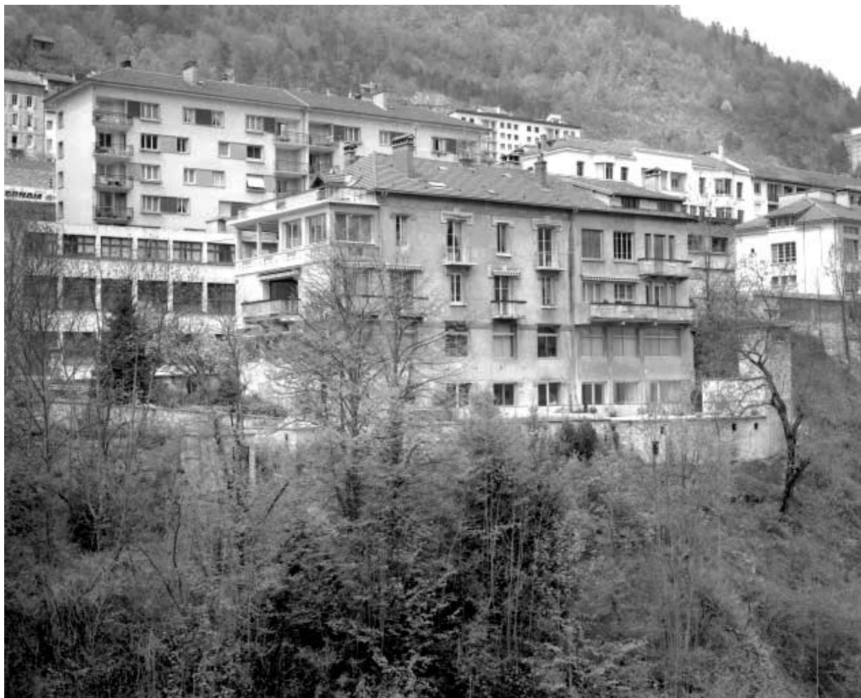
Logements et bureau depuis le sud.
