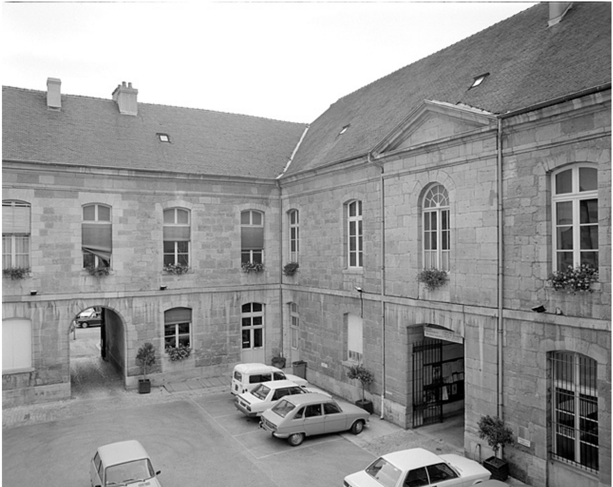
Cour intérieure : côtés est et sud.
