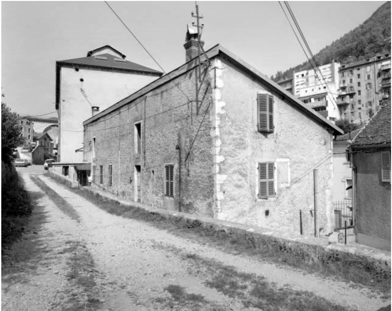
Internat de l'école de formation Dalloz : façade postérieure de trois quarts droite.
