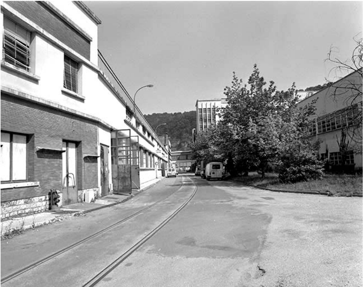
Allée centrale de l'usine A depuis l'entrée. Atelier de réparation à gauche.
