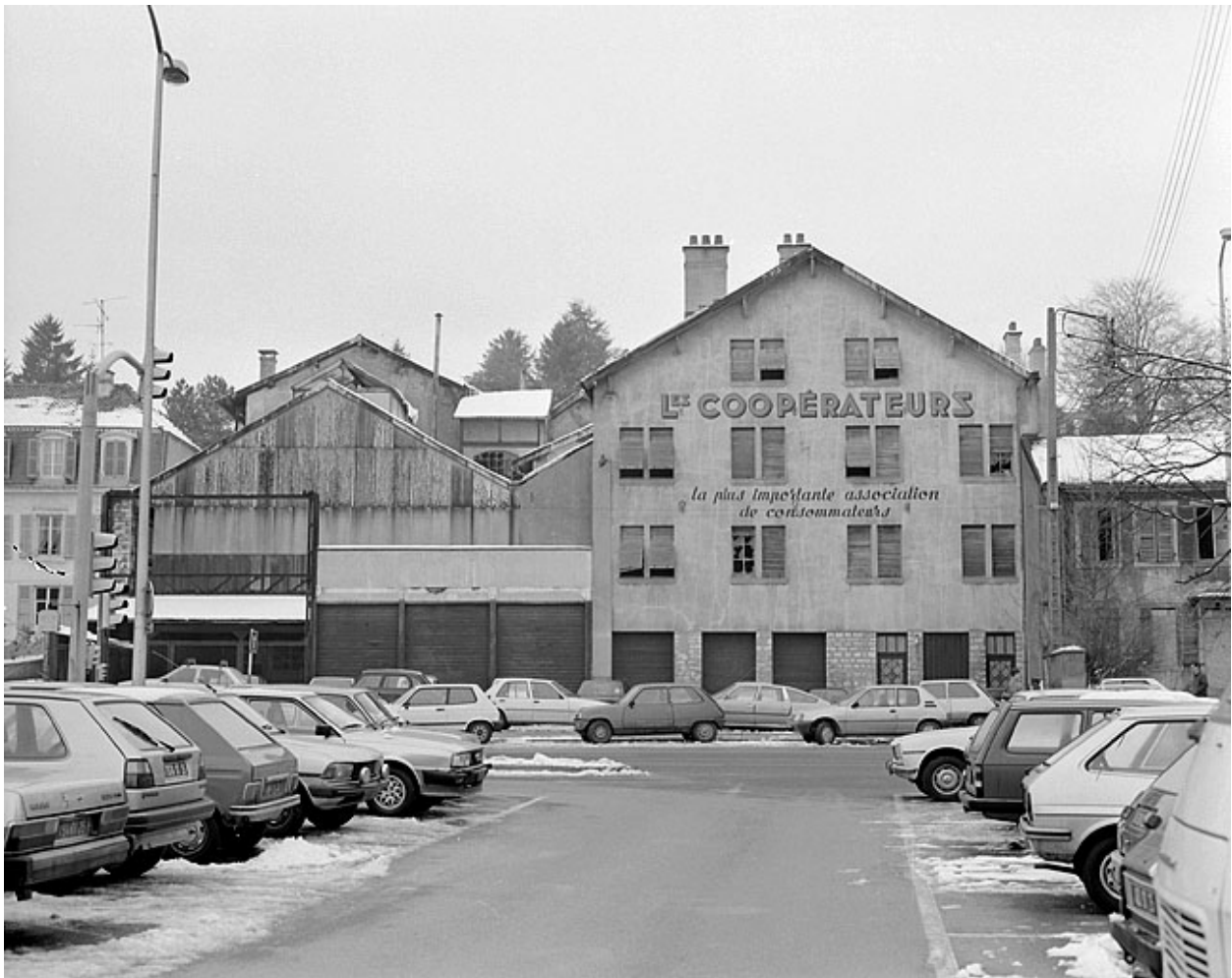
Façades sur la rue des Huisselets.
