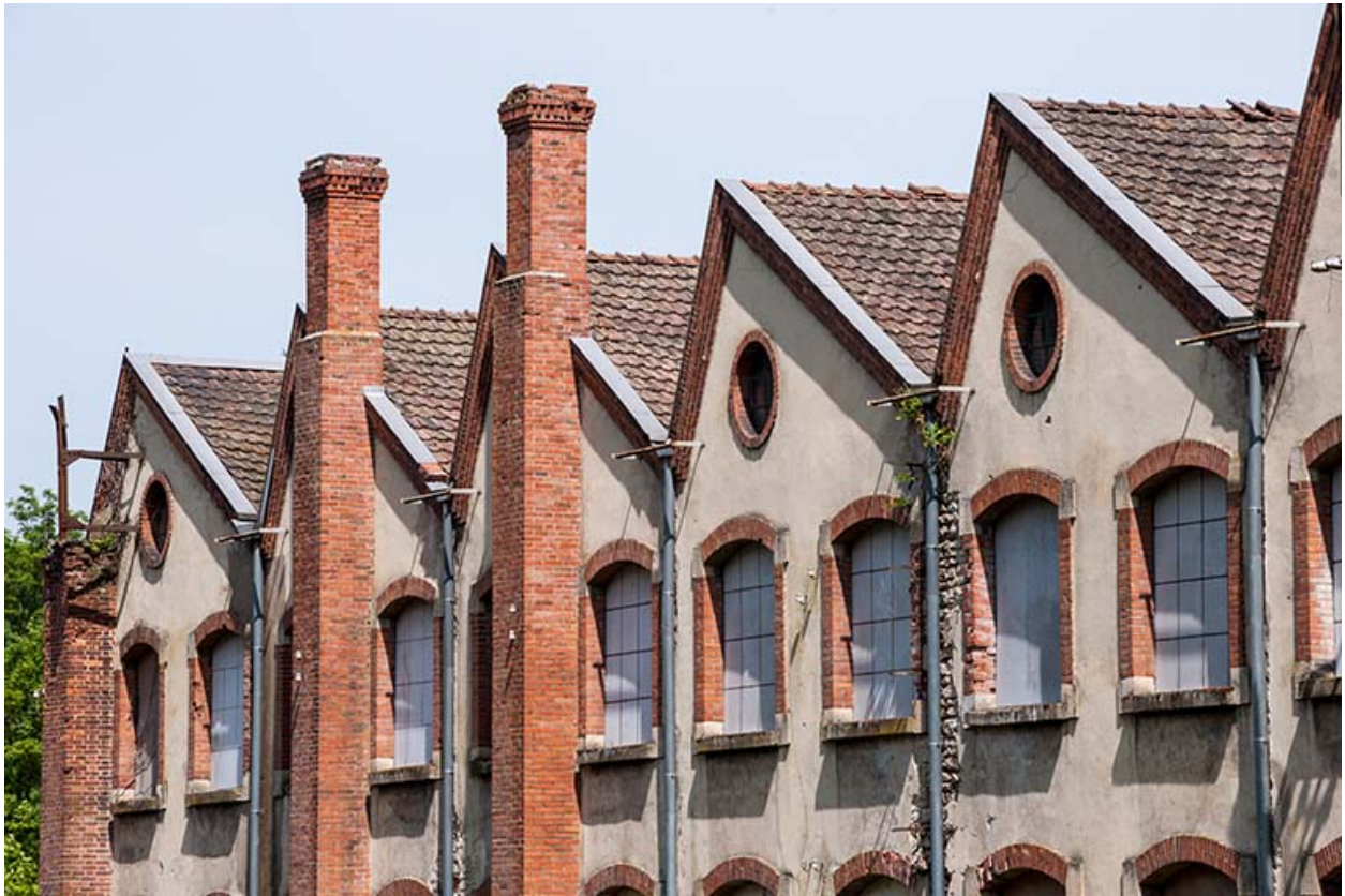
Détail des pignons de l'atelier de fabrication.
