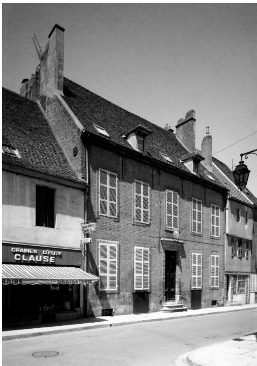
Façade d'une maison, 32 rue de la République.
