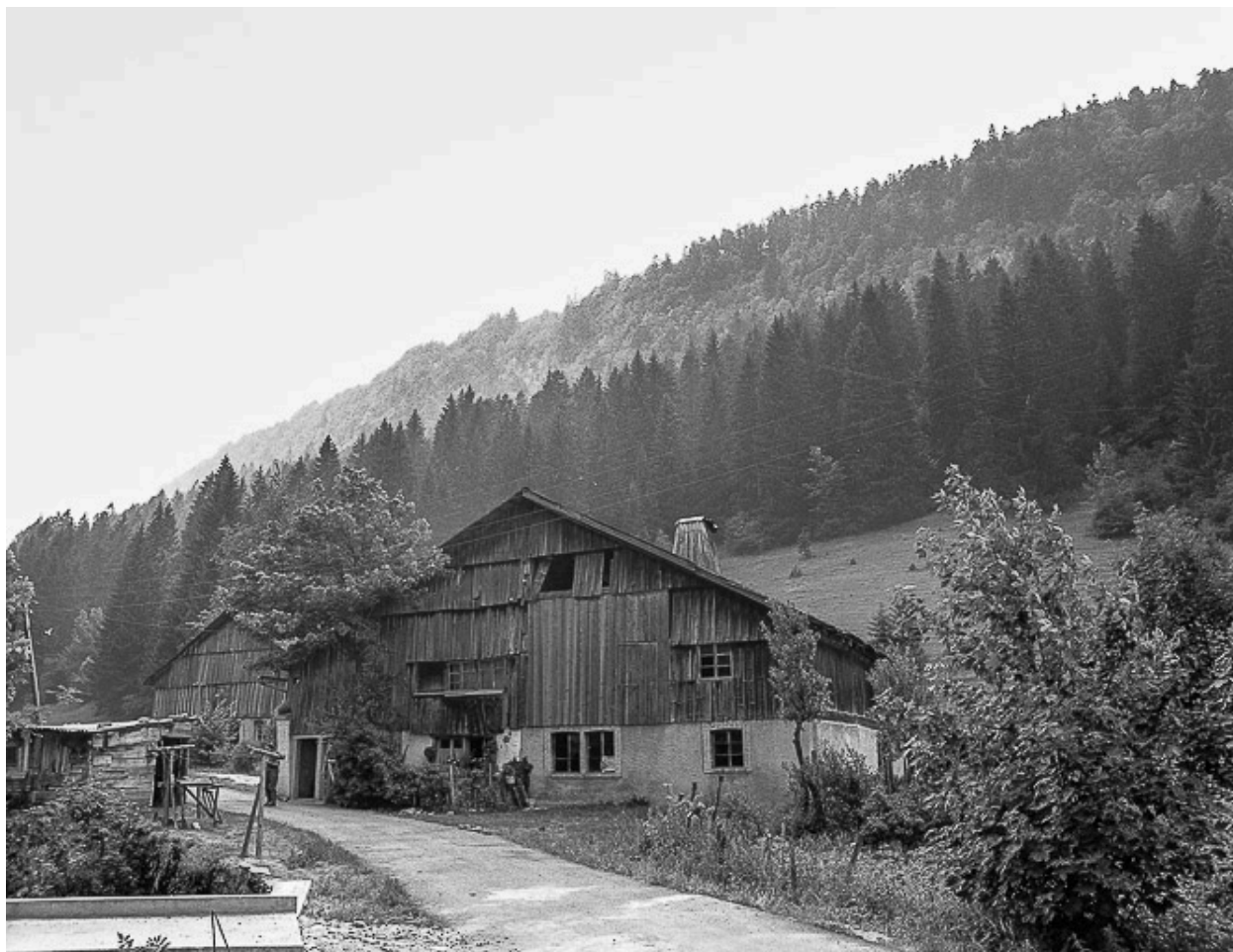
Ferme située au lieu-dit Le Theverot, cadastrée ZL 28 : vue d'ensemble.
