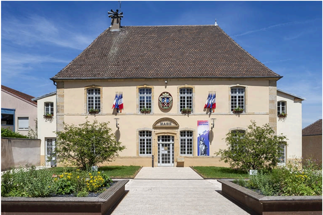
L'ensemble de la façade sud.
