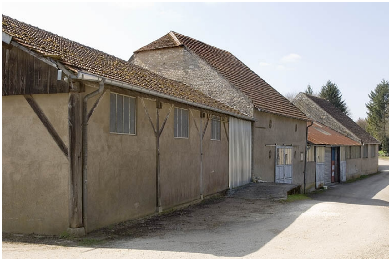
Façade nord de l'ancienne halle à charbon.
