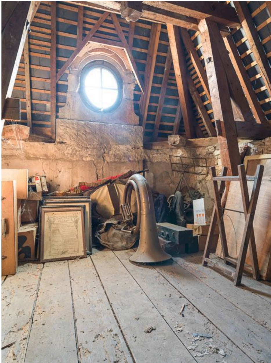
Dépôt d'objets dans les combles de la mairie.
