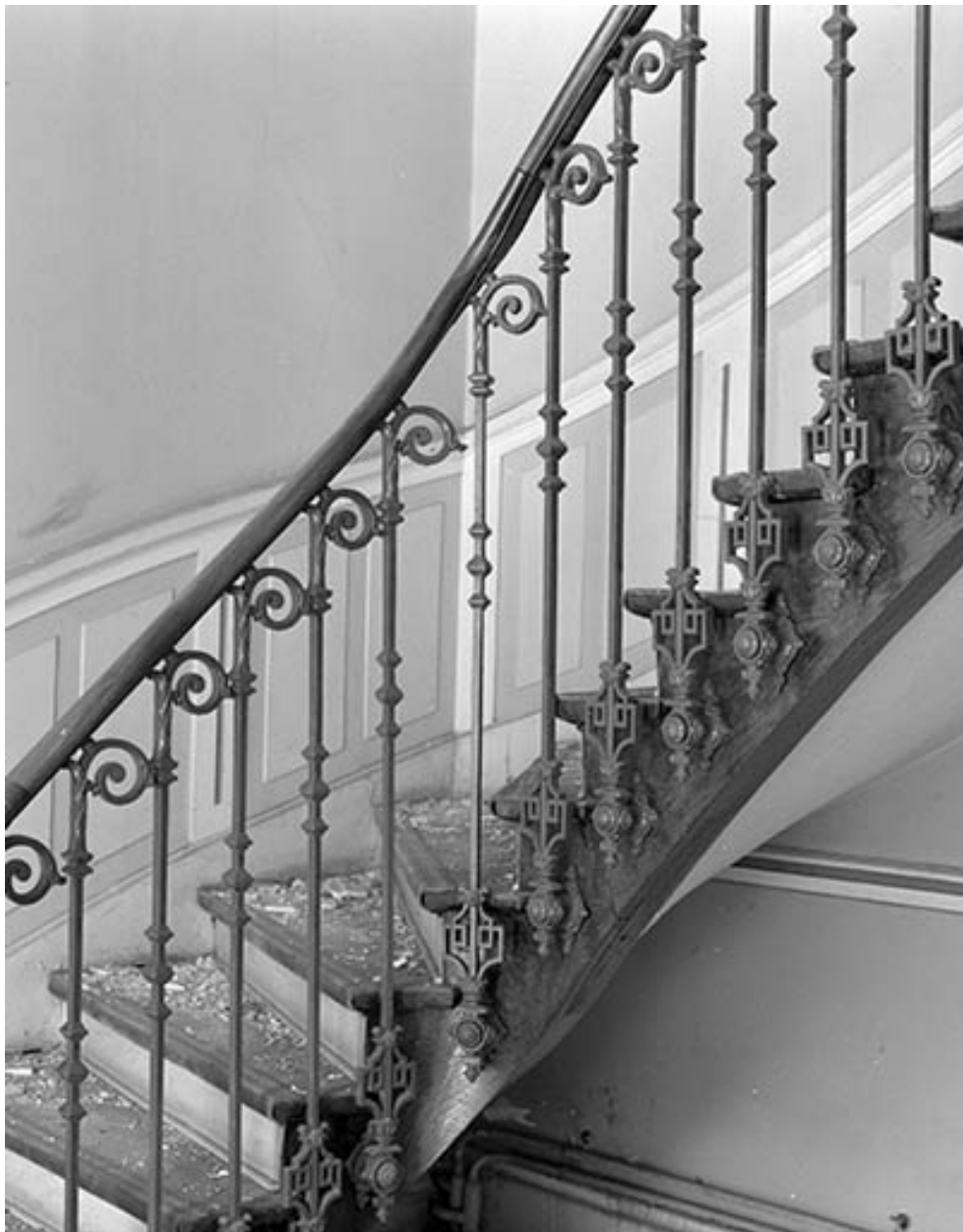
Escalier des bureaux : détail de la rampe.
