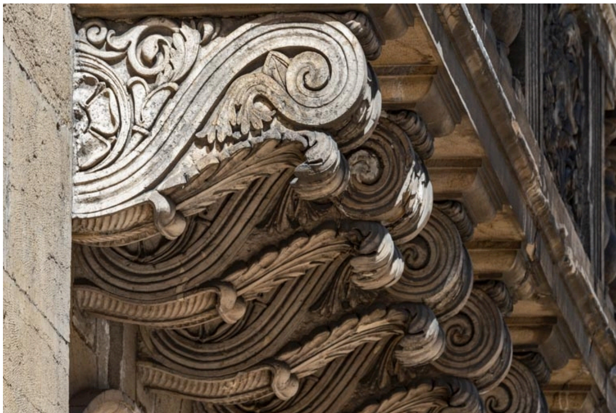
Façade antérieure : consoles du balcon.
