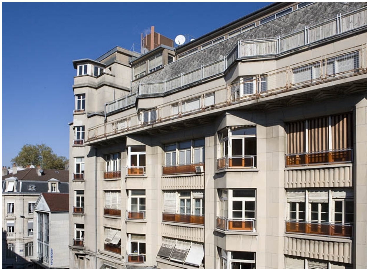
Façade antérieure : détail des étages supérieurs.
