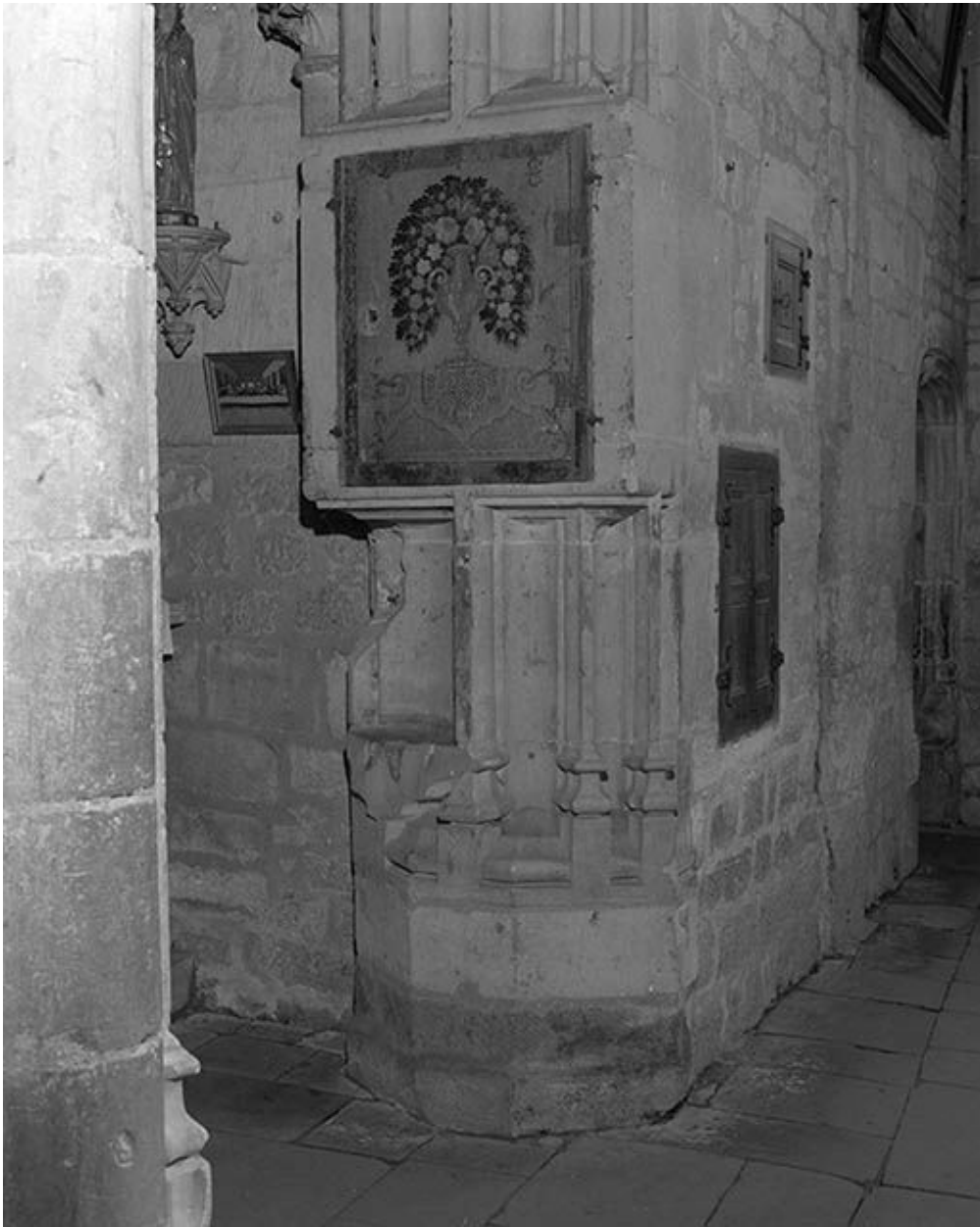
Choeur, mur gauche et armoire aux reliques du piédroit de l'arcade ouvrant sur la chapelle gauche.
