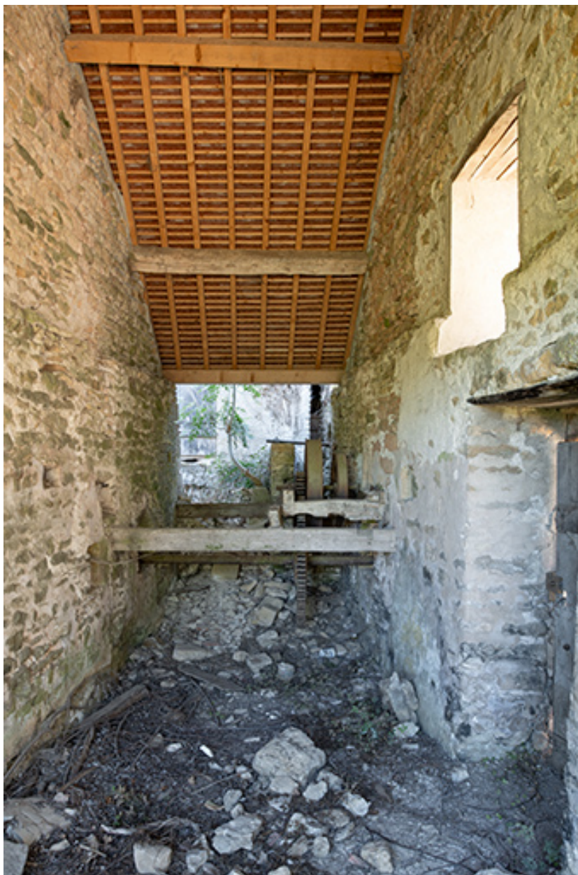
L'intérieur du bâtiment abritant le mécanisme.
