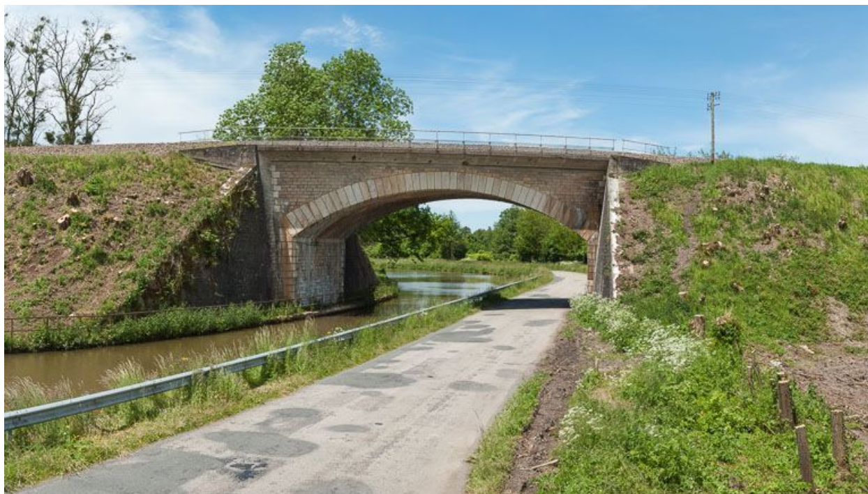
Le pont, vu d'amont.
