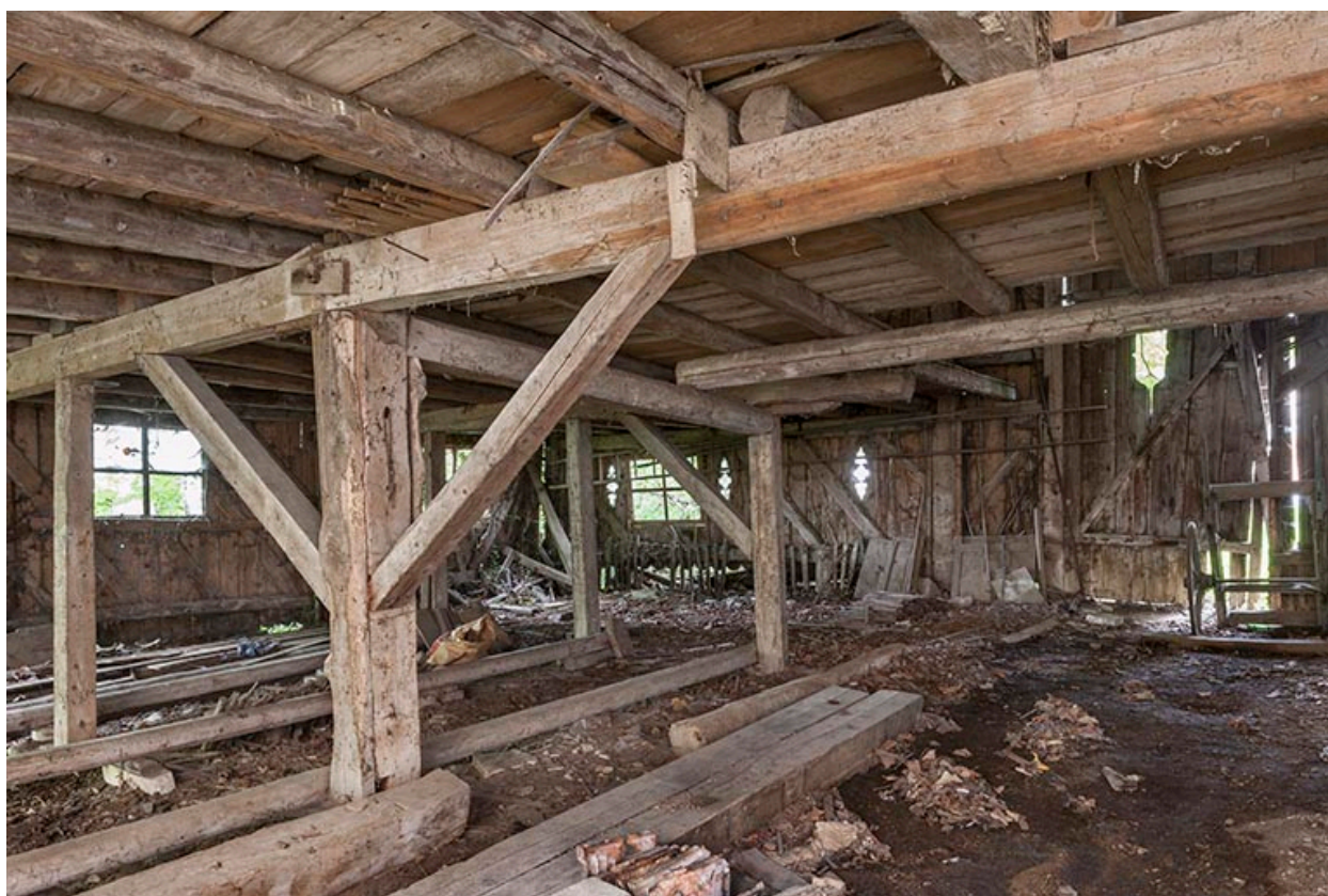
Entrepôt industriel. Rez-de-chaussée.
