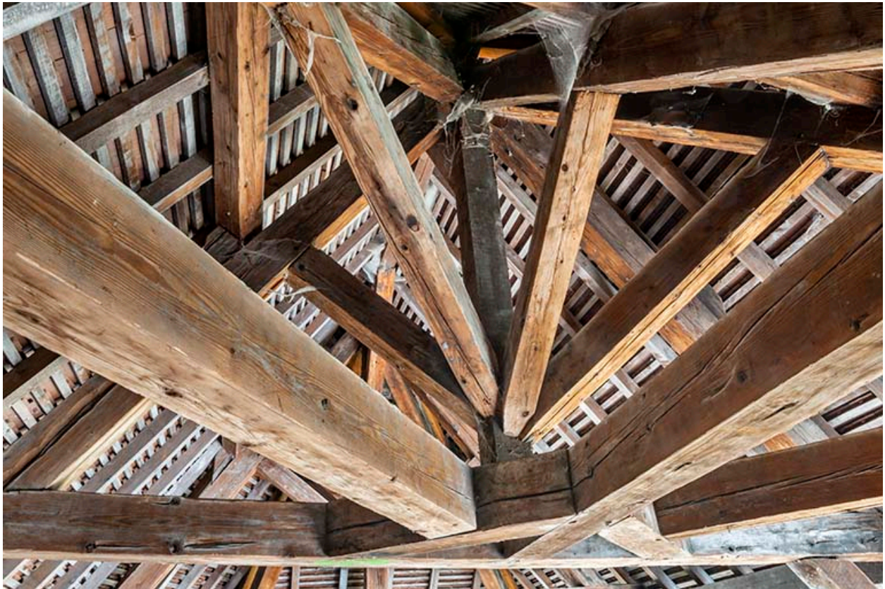
Charpente. Détail de l'enrayure sud.
