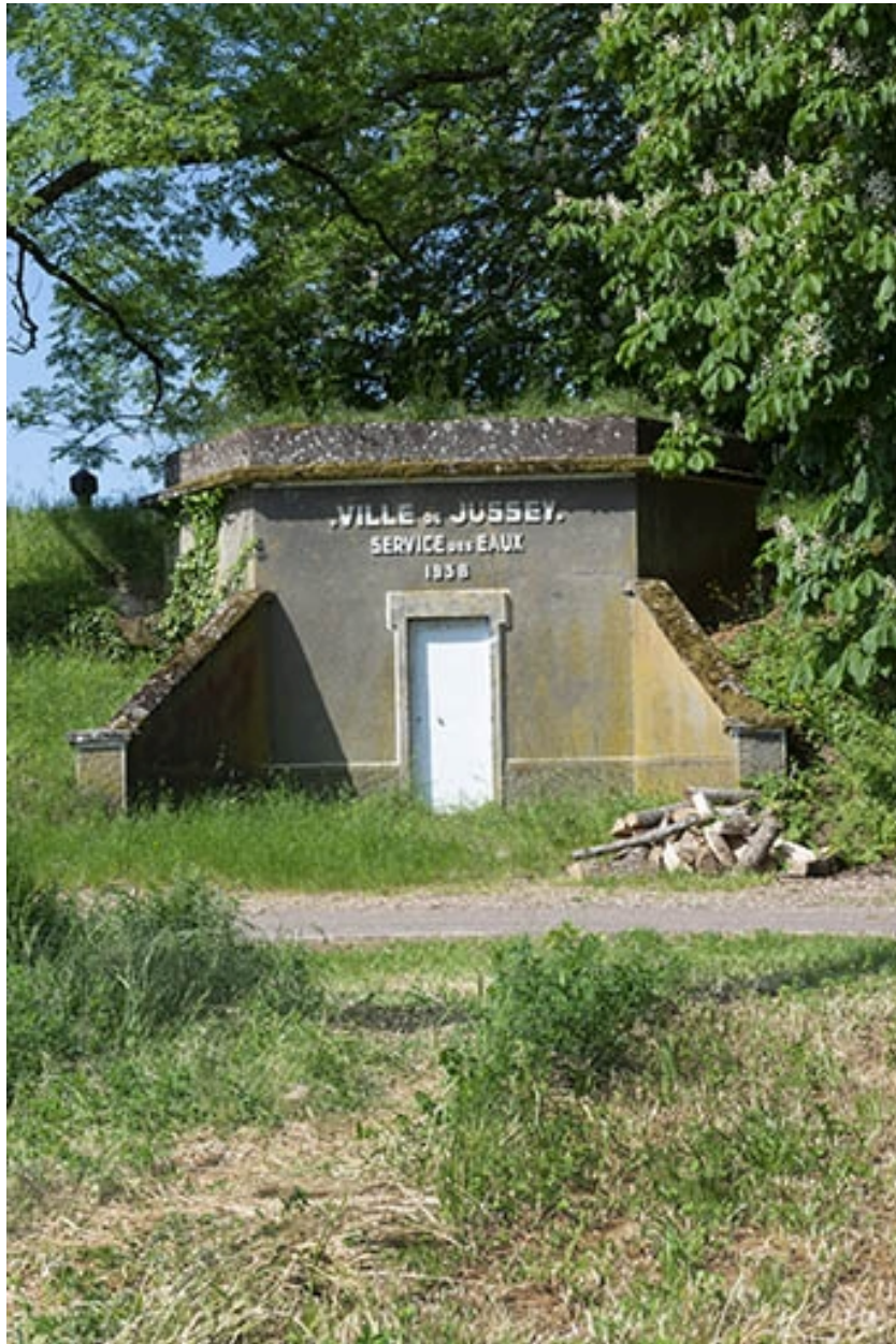
Le château d'eau de la Lanterne, vu de face.
