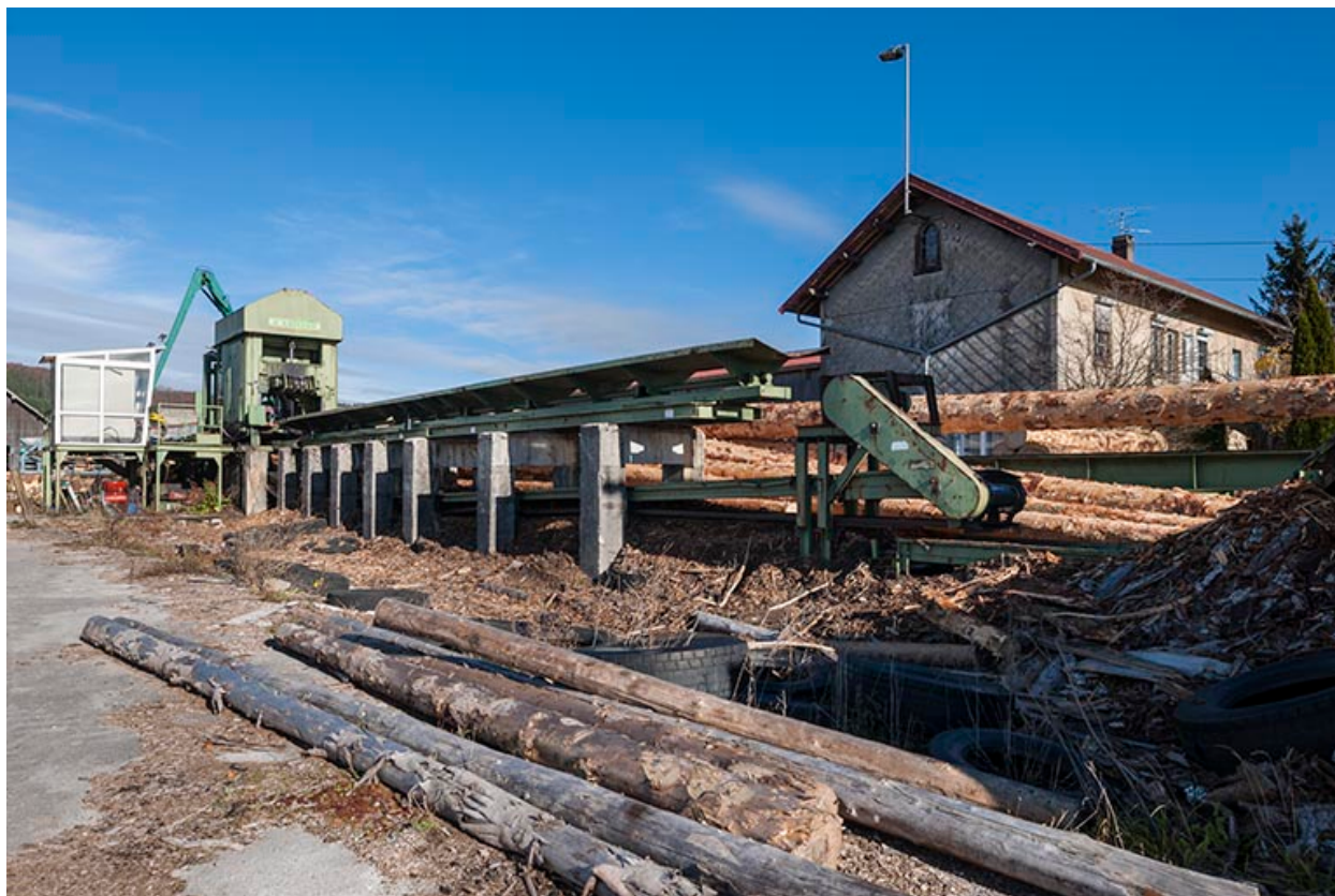
Poste d'écorçage et bureaux.
