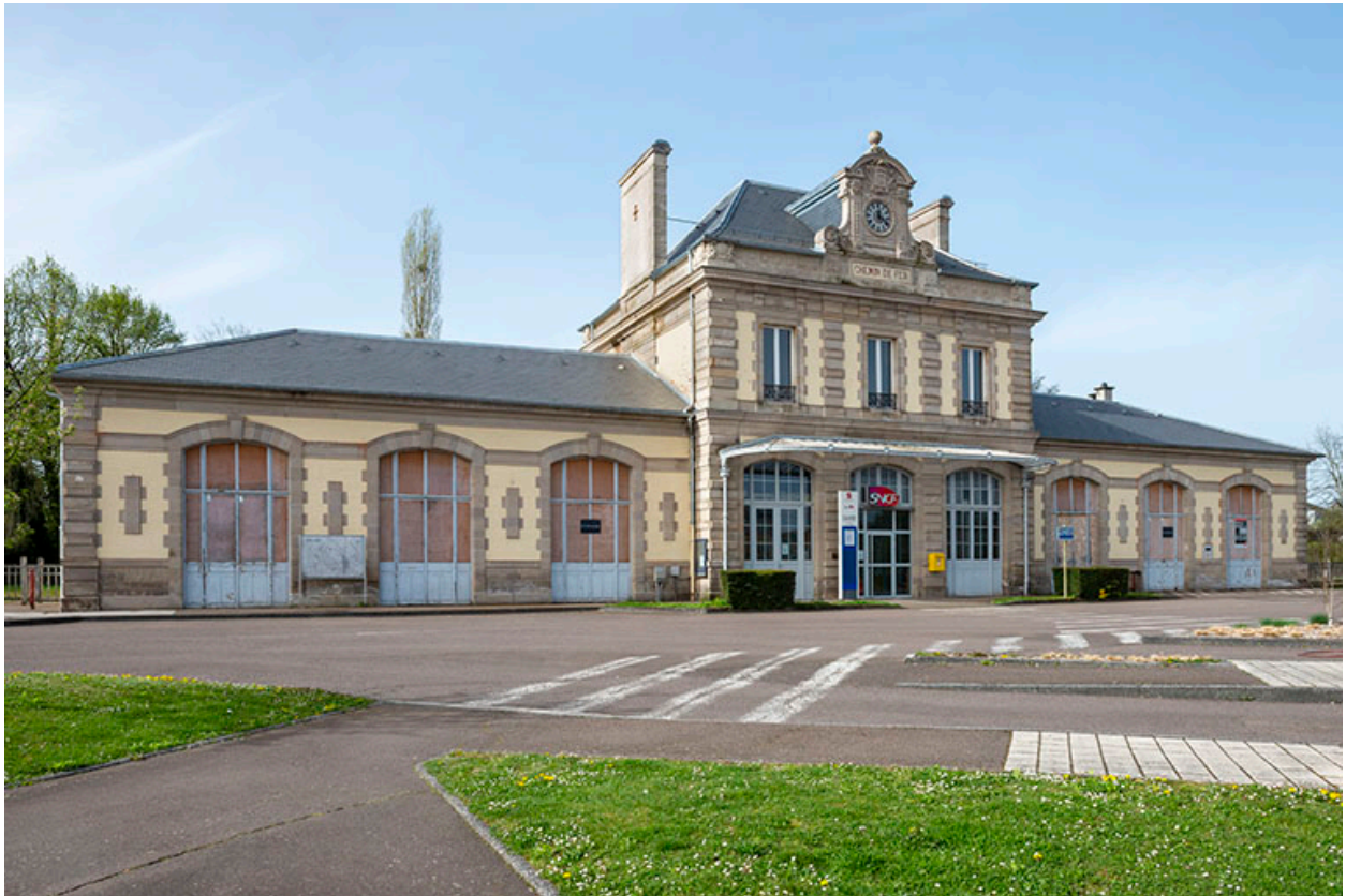
Façade, vue de trois quarts.
