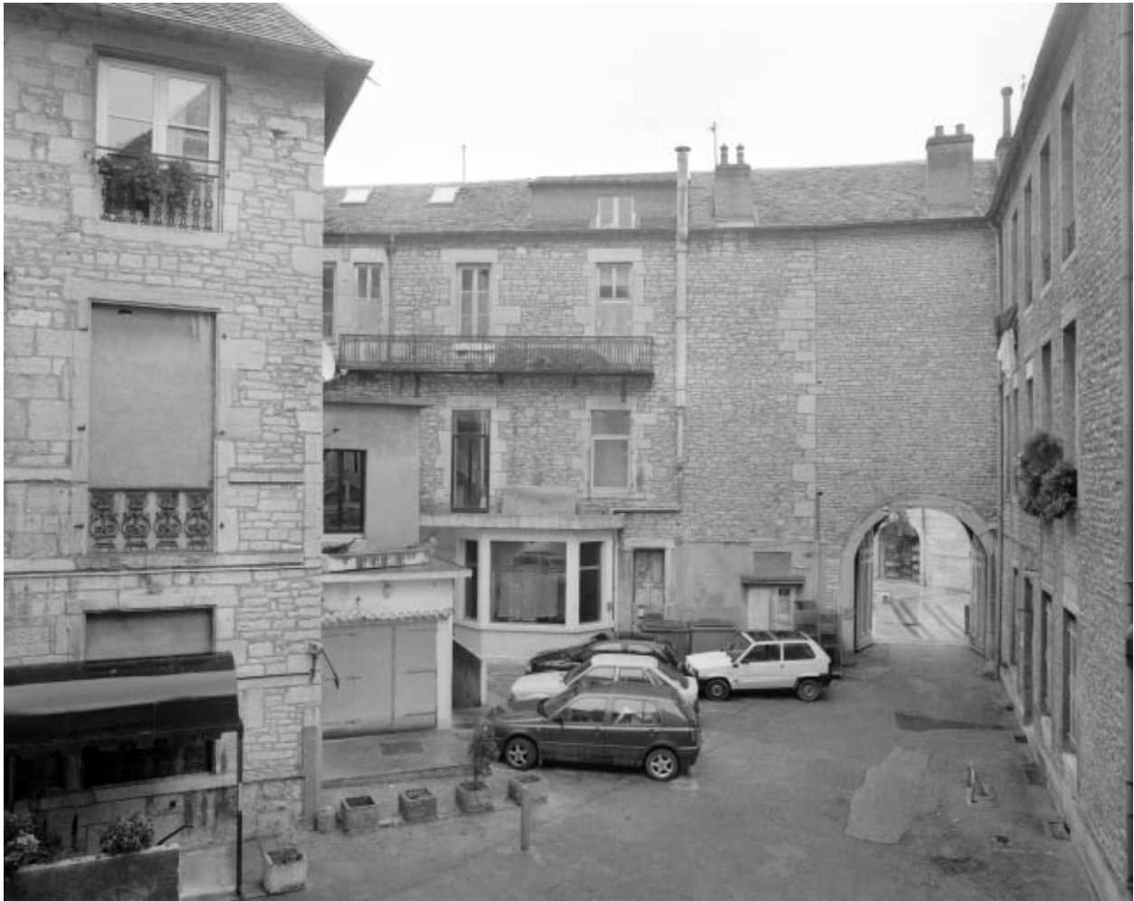
Vue de la cour antérieure depuis le logis sur cour, de trois-quart gauche.
