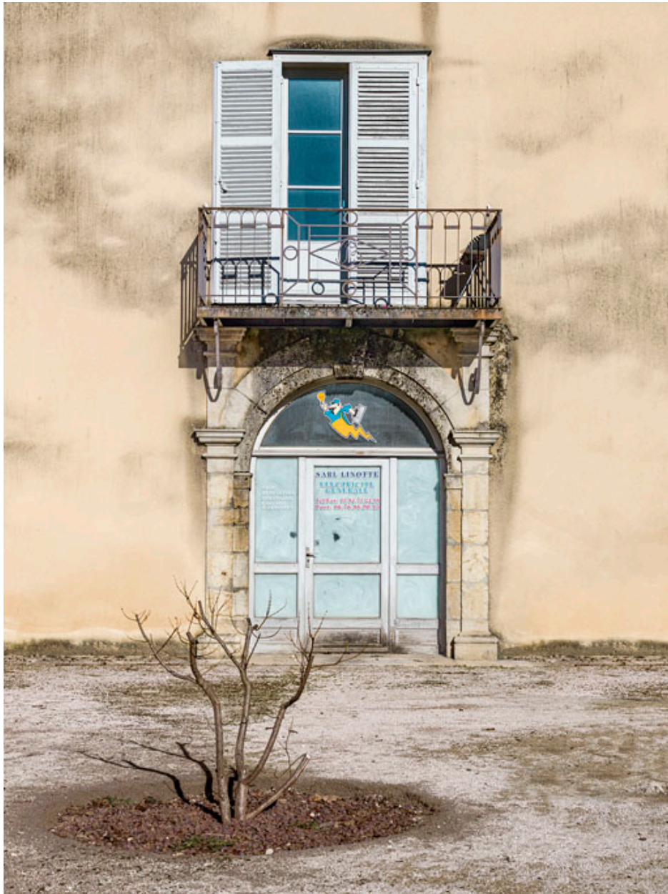
Façade sud de l'immeuble sur rue. Baies réimplantées suite à la démolition des immeubles 27 à 31 rue de la Liberté.
