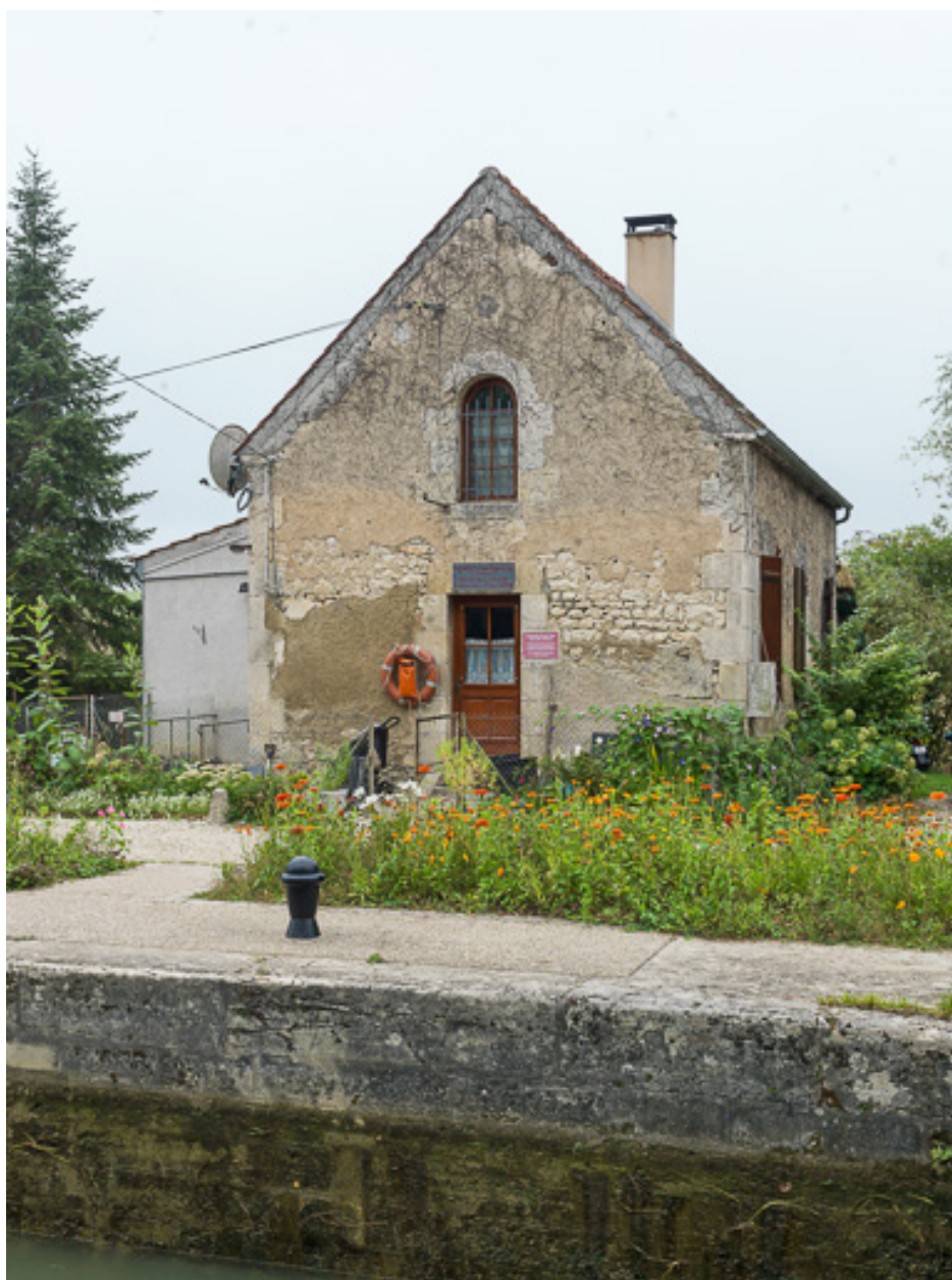
Vue de la maison éclusière.
