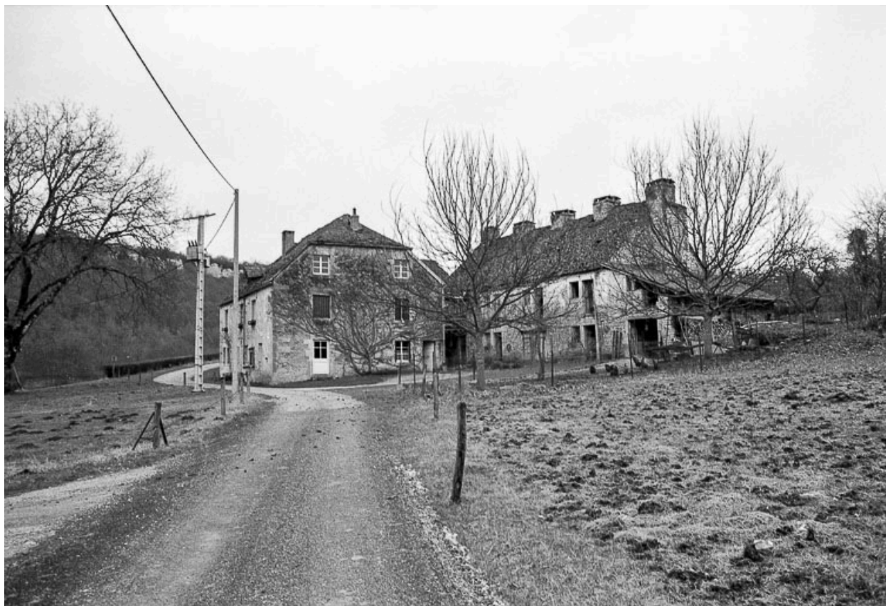
Logements d'ouvriers depuis l'ouest en 1979.
