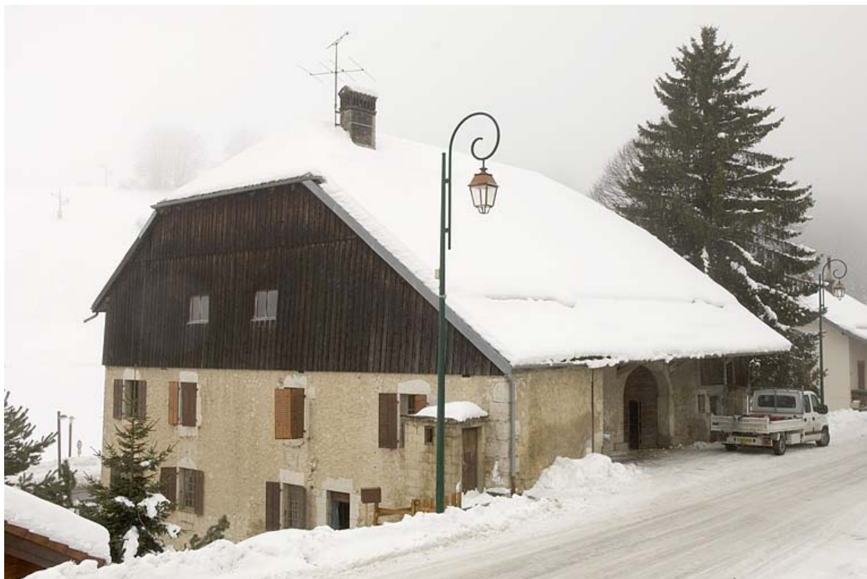
Façades antérieure et latérale gauche, en hiver.
