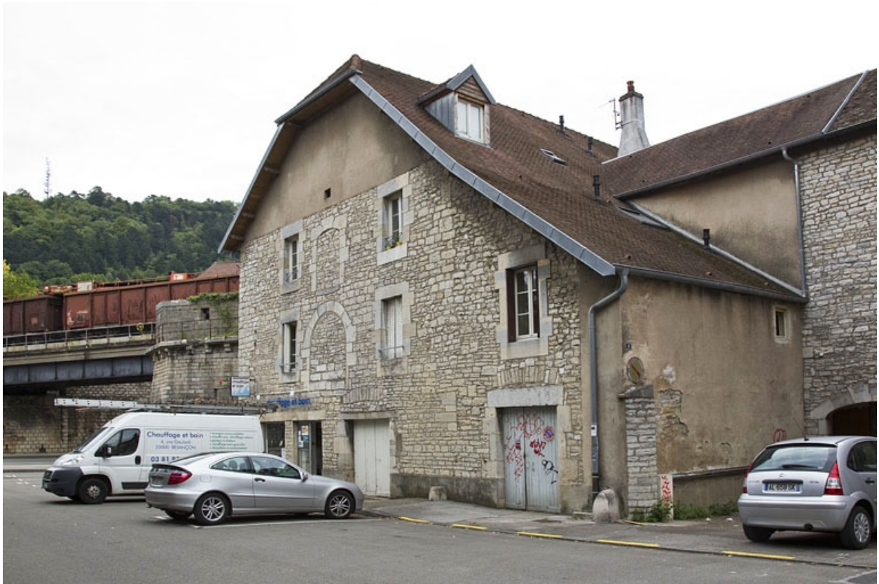
Bâtiment des remises écuries : vue d'ensemble, de trois quarts droit.
