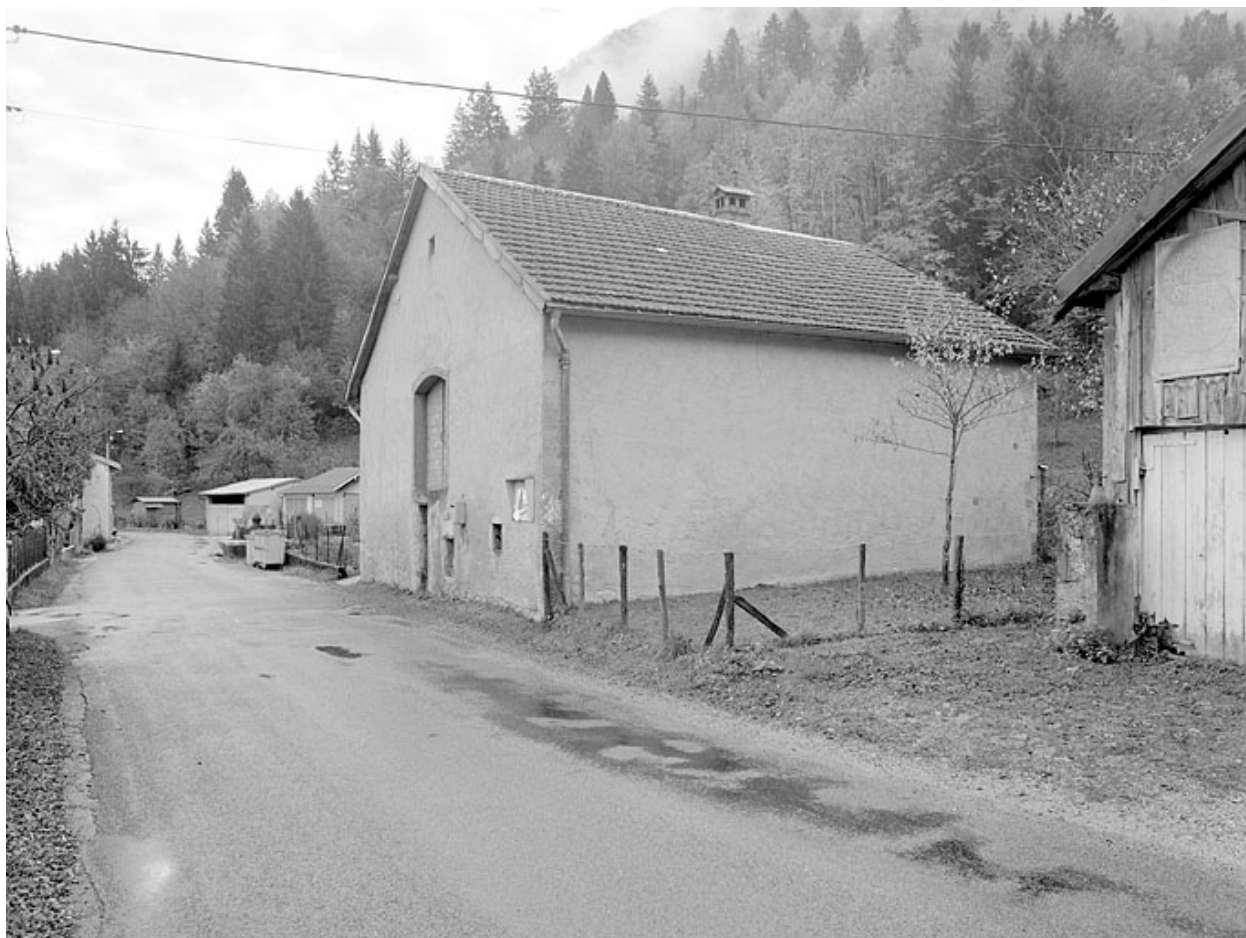
Face nord et façade postérieure.
