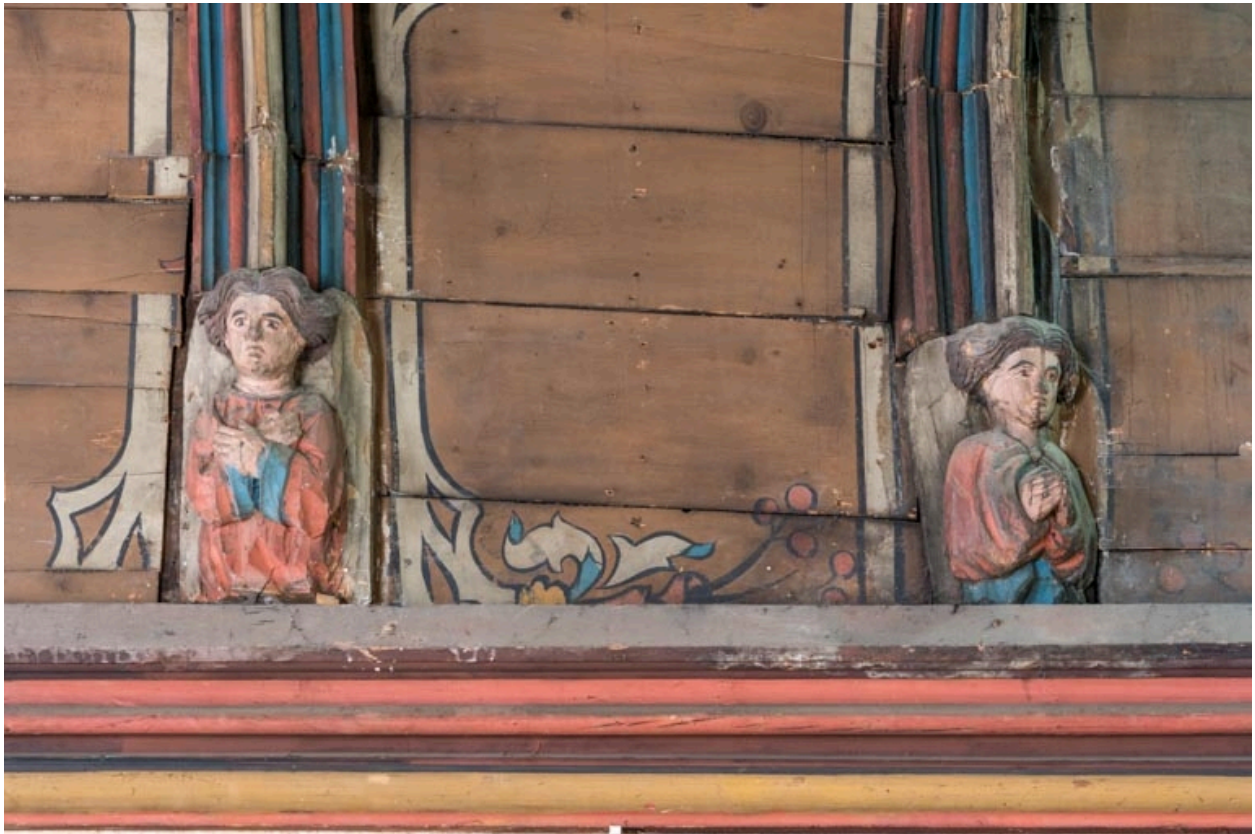
Angle nord-ouest, mur nord : deux anges.
