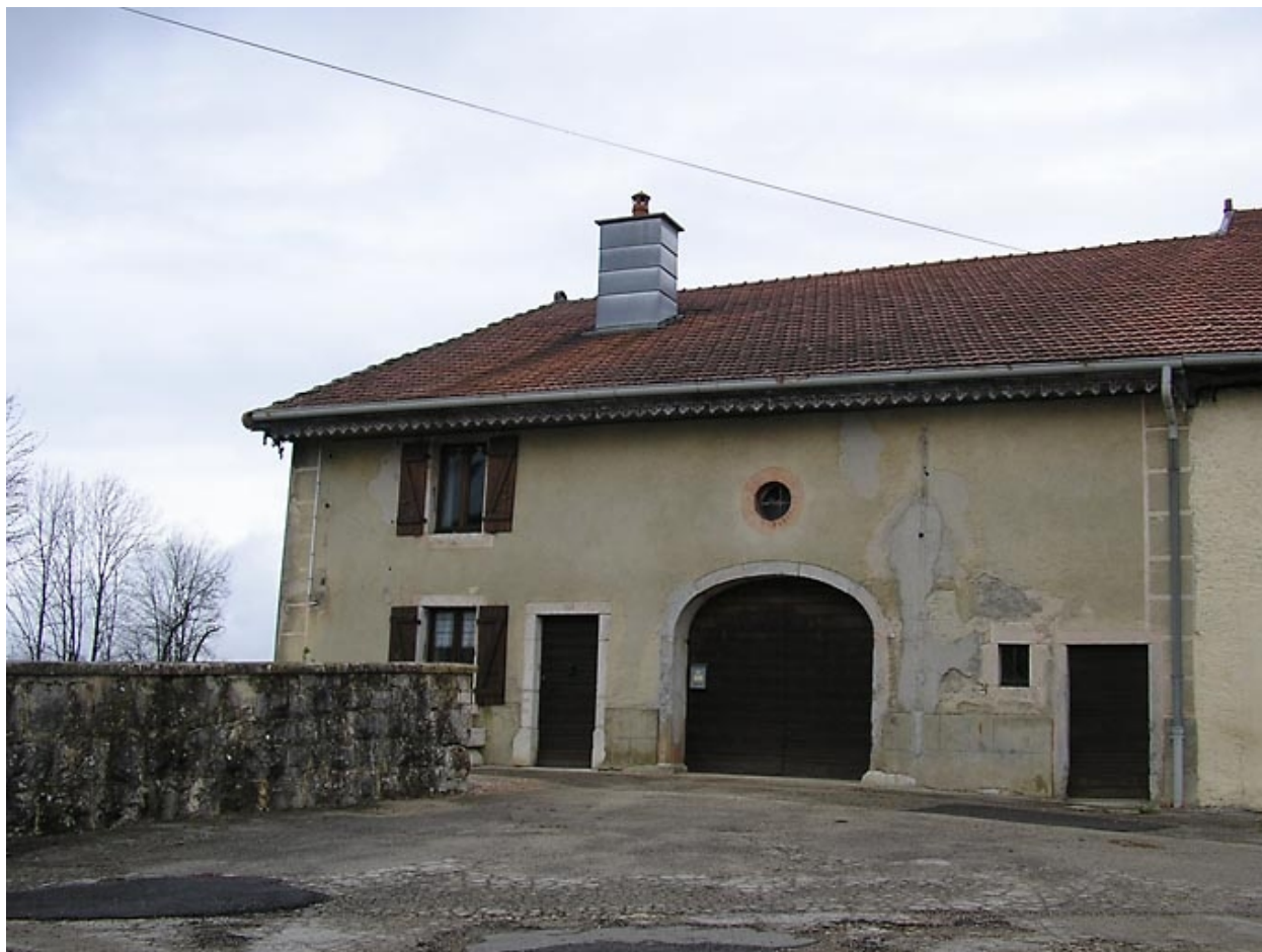
Vue générale de la façade postérieure.
