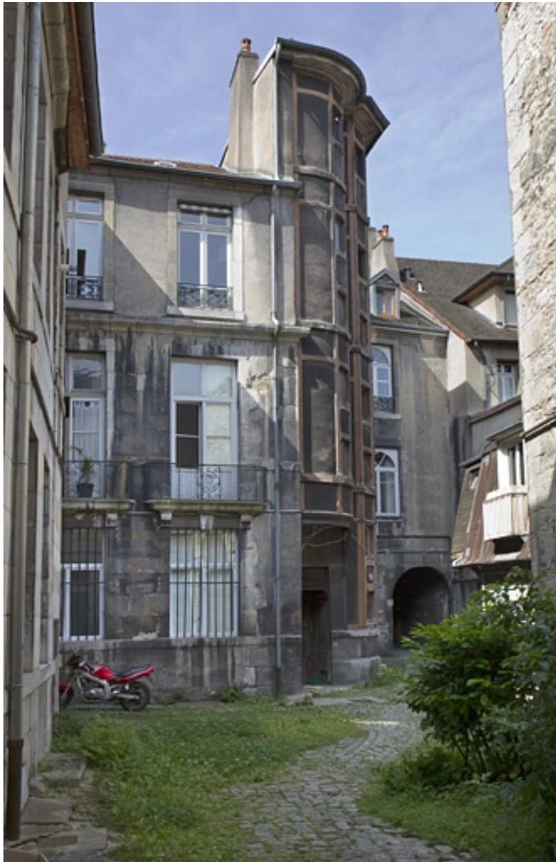
Vue d'ensemble du logis principal depuis le fond de la cour.
