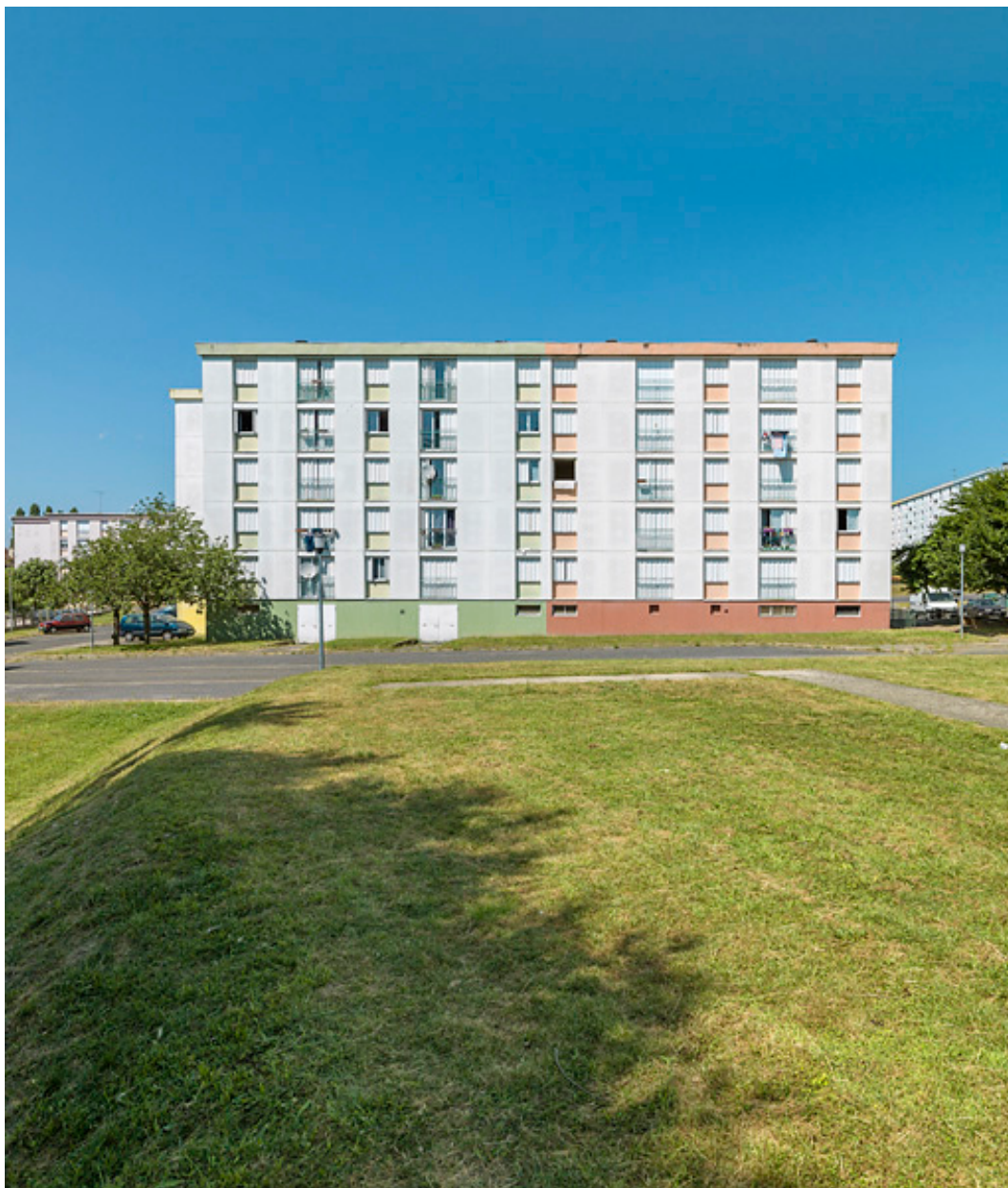
Bâtiment B-5, façade postérieure.
