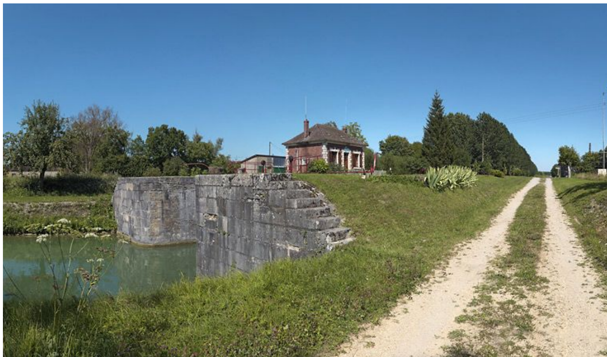
Vue de la tête amont du sas.
